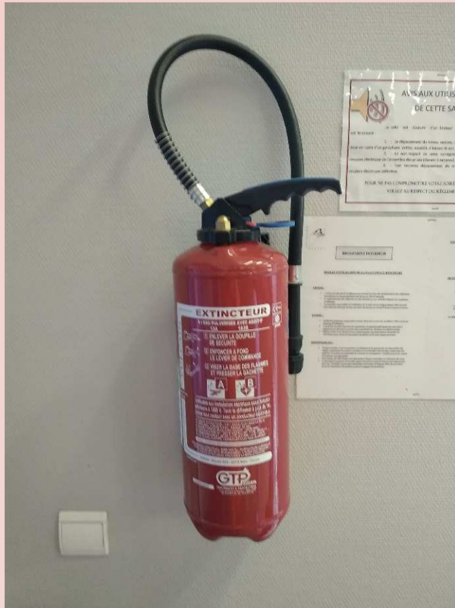
Extincteur à eau pulvérisé AB A pression auxiliaire Avec ou sans additif
